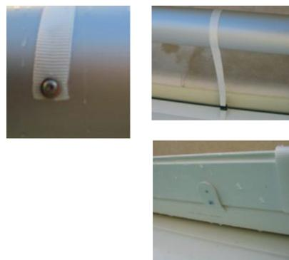
Les skis, permettent d'orienter la dernière lame du volet pour faciliter le déroulement.
